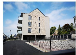
Immeuble collectif, rue Quesnel-Morinière (80 logements/ha)
